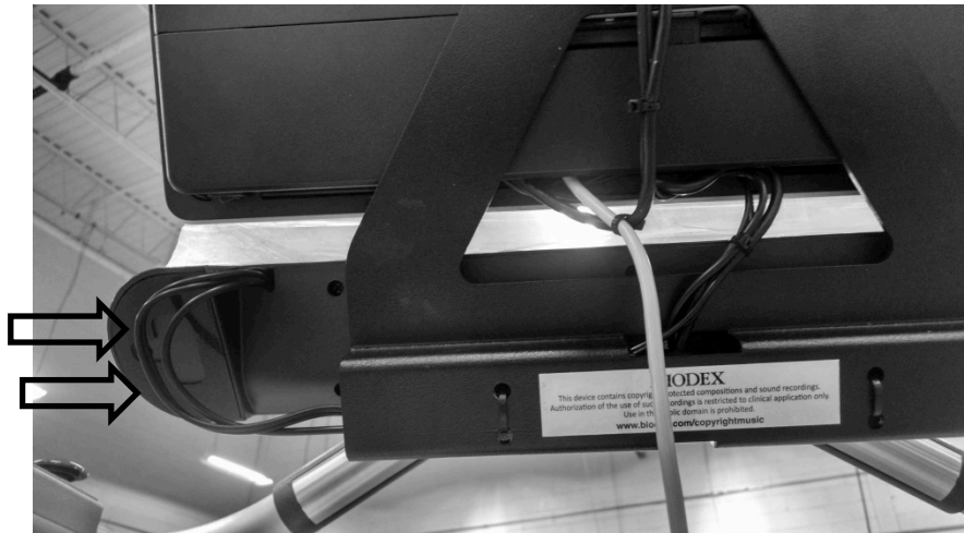
Abbildung 11.4. Die Strom- und Tonkabel der Soundleiste (Pfeile).
